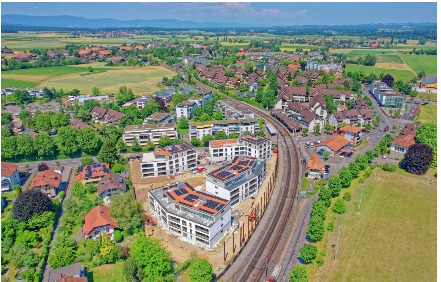
Drohnenaufnahme Viermoos mit Blick Richtung RBS Bahnhof Schönbühl Zentrum - Juni 2026
